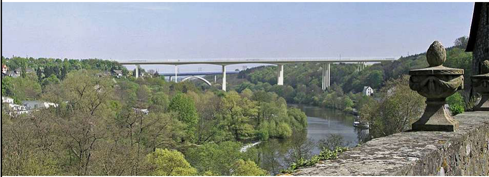
Lahntalbrücke Limburg, A3
