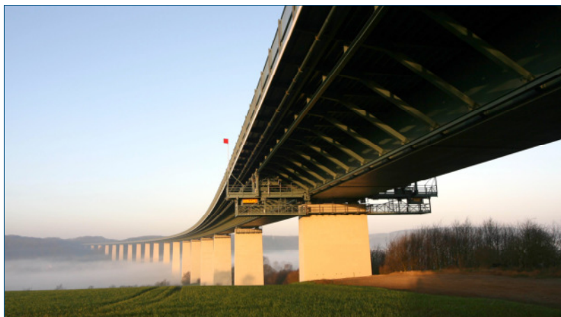
Talbrücke Mintard, A52
