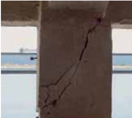
Abbildung 10: gerissener Stützenkopf
