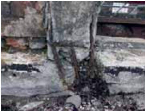
Abbildung 13: Stützenfuß Obergarde
