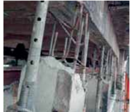
Abbildung 12: freigelegte Stützenköpfe
