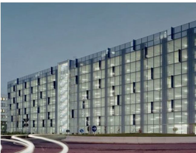
Neubau Parkhaus METRO Düsseldorf
