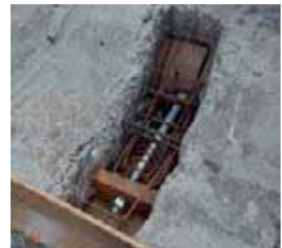
Abbildung 9: neuer Zugstab
