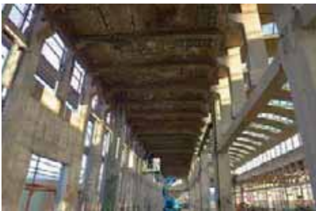
Abbildung 22: Betonabplatzungen im Seitenschiff
