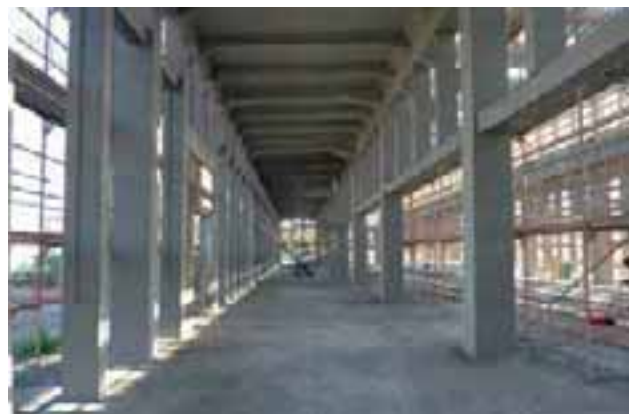
Abbildung 23: Instandgesetzte Betonflächen
