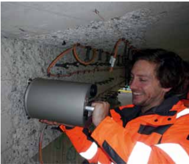
Bild 5: ELAtextur®-Gerät mit rotierendem Laser im Baustelleneinsatz
