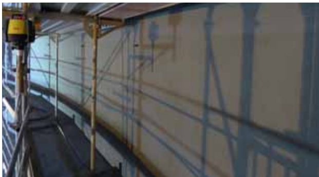
d) Lage- und Höhenkontrolle während des Textileinbaus
