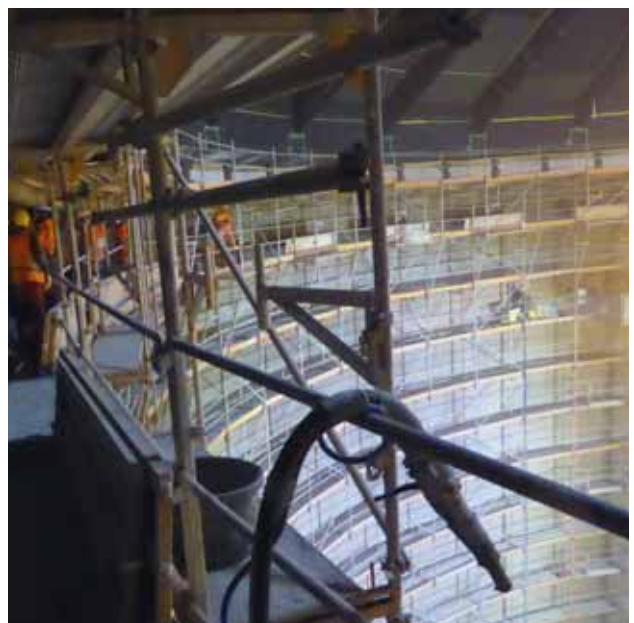
Bild 6: Baustelleneinrichtung mit Mischplatz und Förderweg für den Instandsetzungsmörtel PAGEL TF-10
