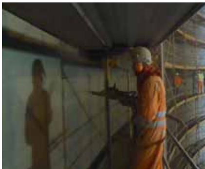
a) Auftragen des Feinbeton Pangel TF-10 im Nassspritzverfahren
