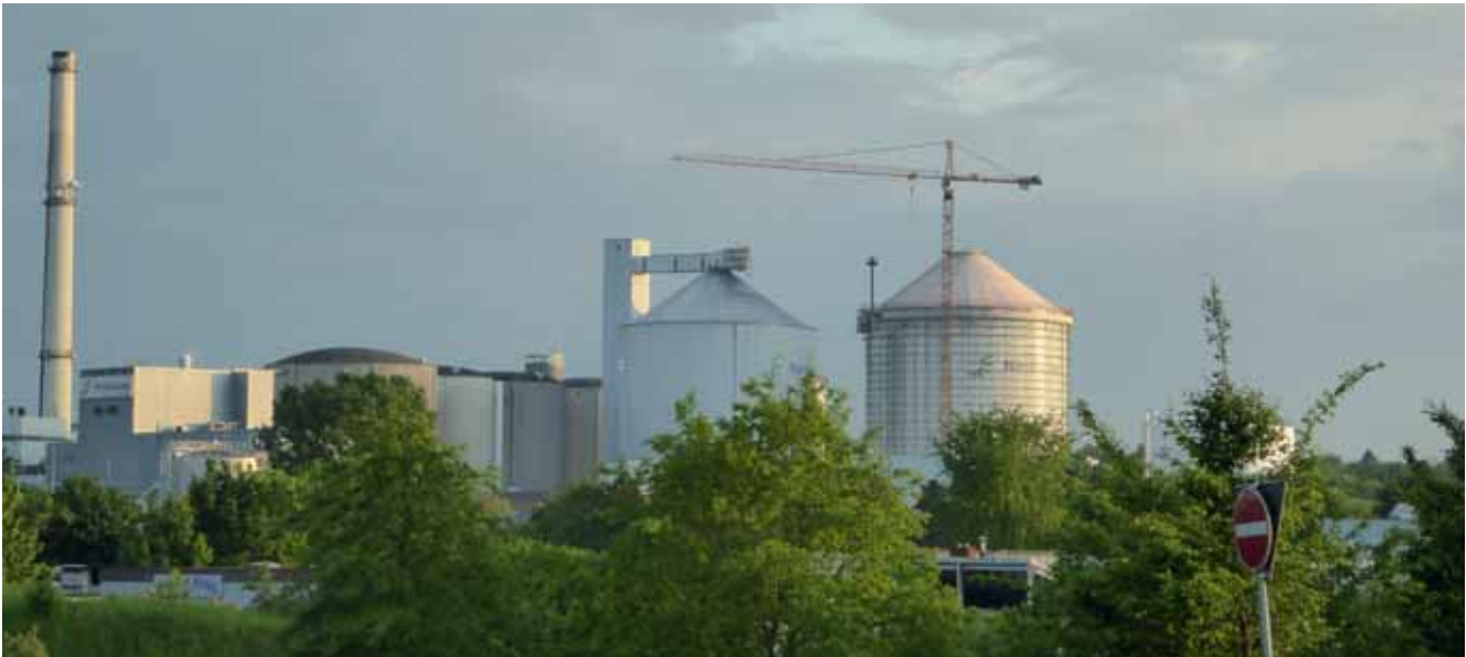
Bild 4: Zuckerfabrik Uelzen mit im Wiederaufbau befindlichen Silo
