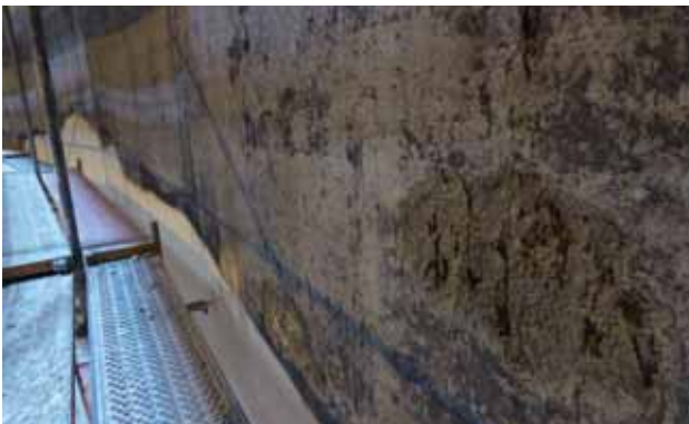
Bild 5: Schadensbild nach Brandeinwirkung an Siloinnenfläche
