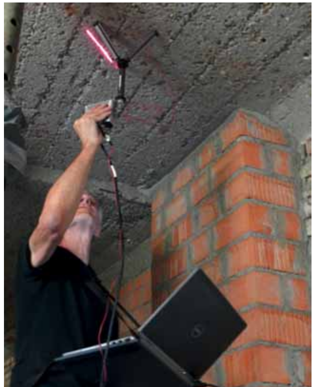
Bild 6: Linienlaser im Baustelleneinsatz
