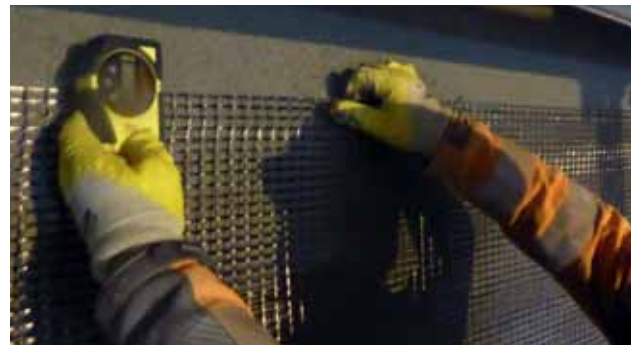
c) Einlaminieren der Carbonbewehrung
