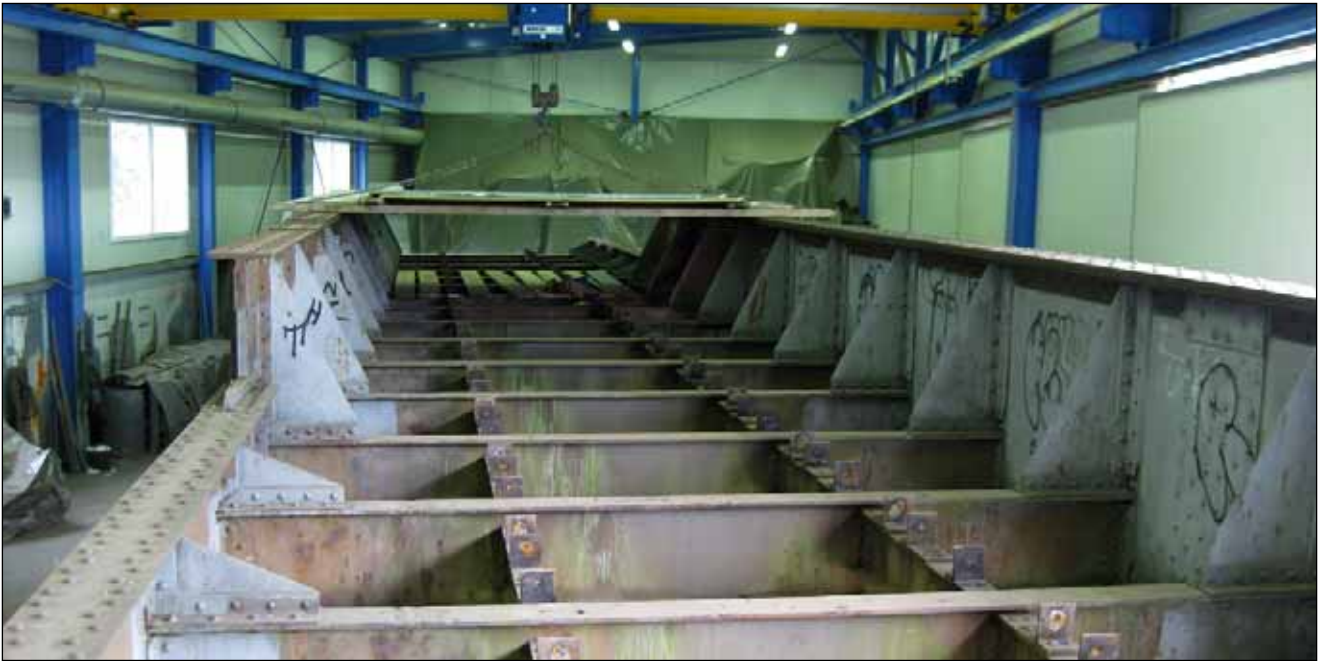
Bild 1: Tragkonstruktion einer Brücke in einer Strahl- und Beschichtungshalle
