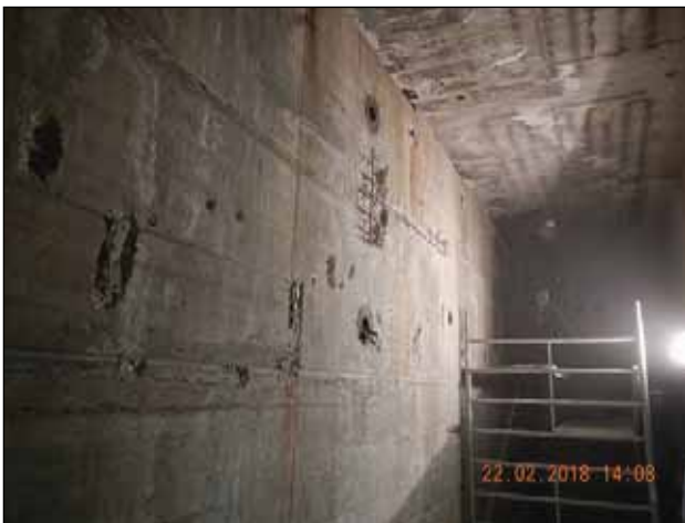
Bild 2: Typische Anwendungsfälle von Betonersatz (RM): kleinflächige Reprofilierung im Handauftrag.
