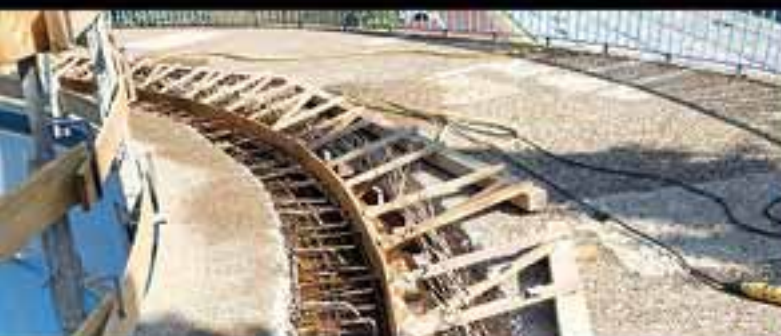
Betonage Auflagerfuge Gleitlagerkonsole
