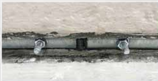
DESOI Quick Seal - Fugensanierung
