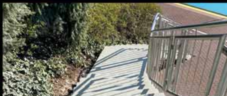
Beschichtung der freitragenden Treppenanlage mit neuen Edelstahlgeländern
