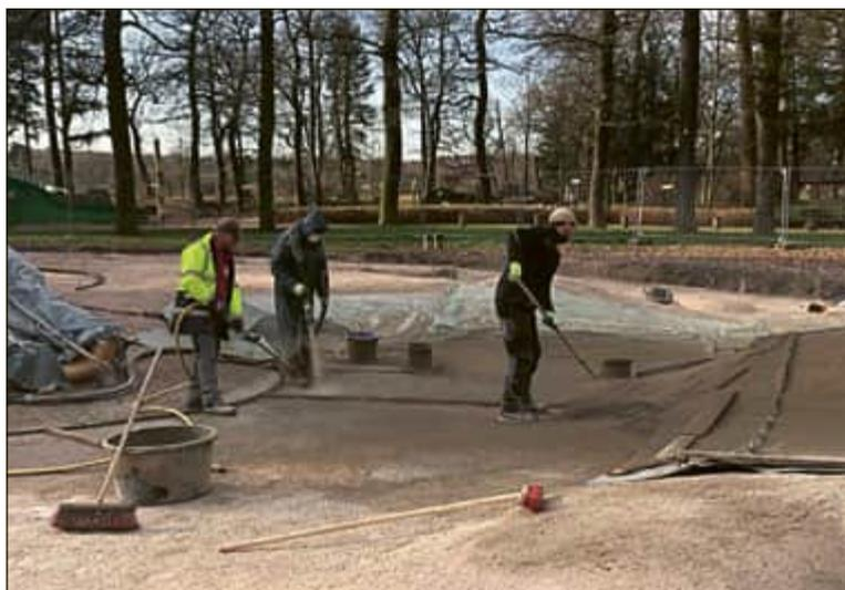
**Bild 15:** Applikation des Spritzbetons + Druckluftlanze
