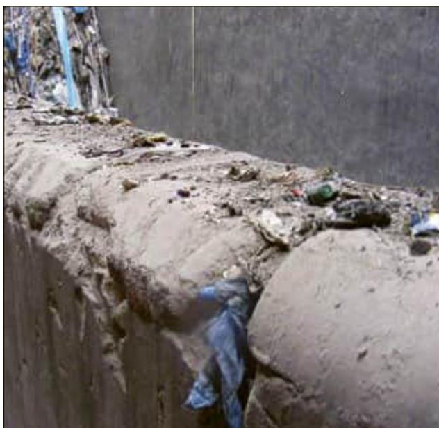
**Bild 1:** Schadhafte Betonflächen
