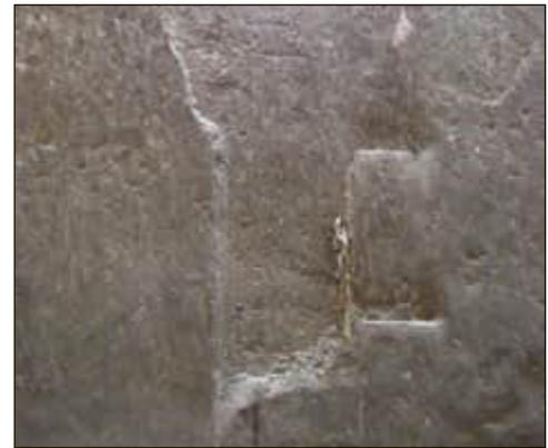
**Bild 8:** Mechanische Schäden durch den Greifarm
